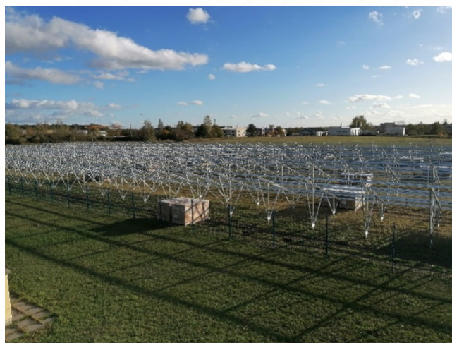
Abbildung 8: Unser Solarpark wird aufgebaut. Inbetriebnahme Anfang 2025.
