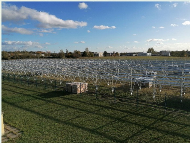
Abbildung 8: Unser Solarpark wird aufgebaut. Inbetriebnahme Anfang 2025.
